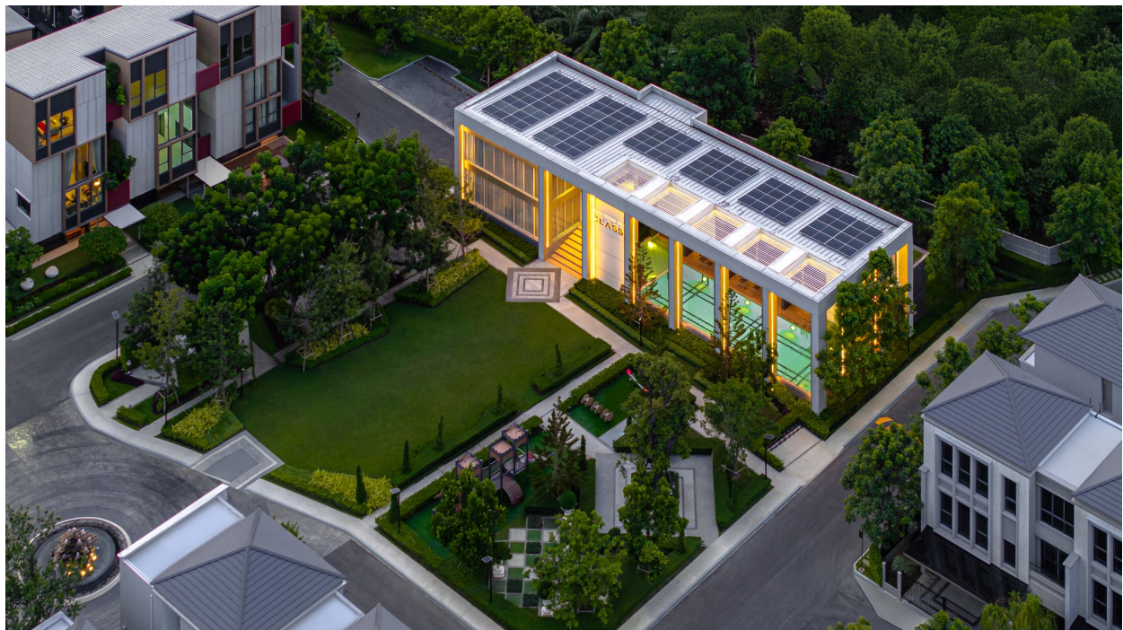
การติดตั้งโซลาร์เซลล์
